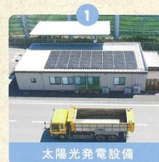
太陽光発電設備
