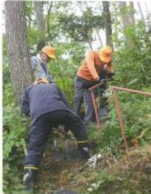
里山の遊歩道の整備を行う団体
