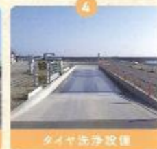
タイヤ洗浄設備
