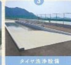
余水処理施設
